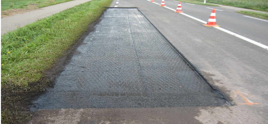
Gedeeltelijk frezen van een deklaag
